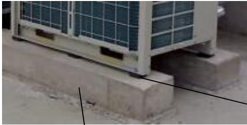
Base em betão
